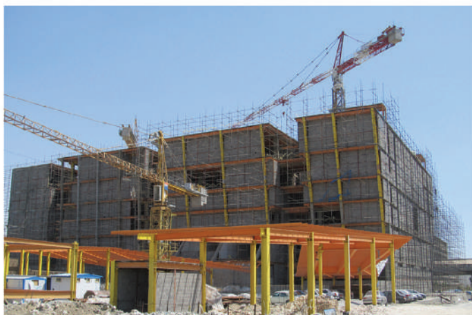
دید شمال غربی پروژه در حال ساخت
