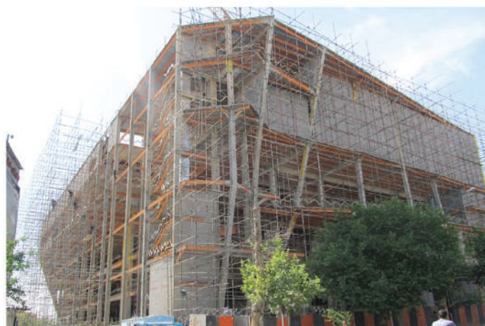
دید جنوب شرقی پروژه در حال ساخت
