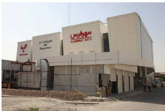
دید شمال غربی پروژه بعد از اتمام
