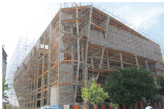
دید جنوب شرقی پروژه در حال ساخت
