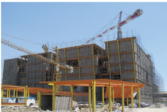
دید شمال غربی پروژه در حال ساخت
