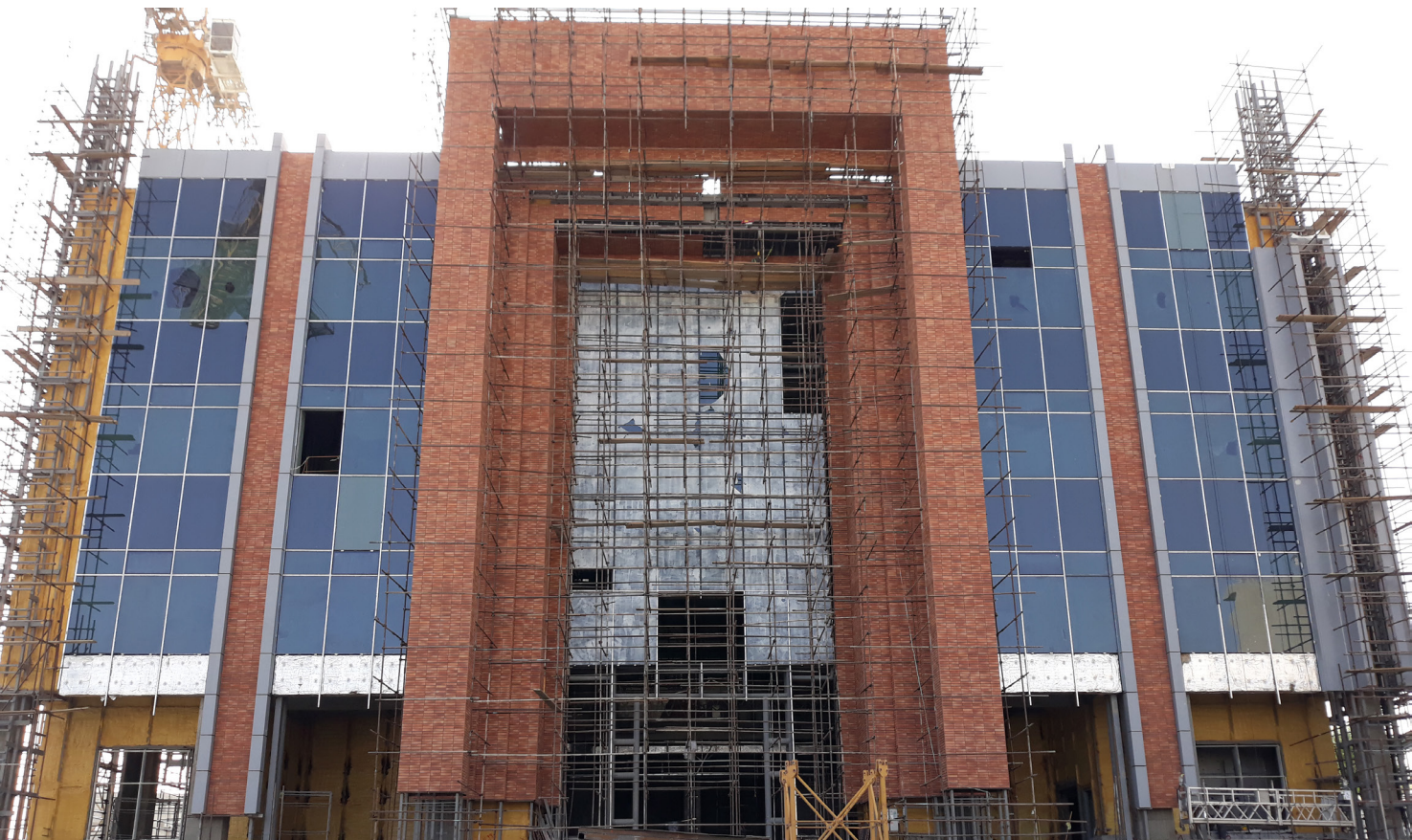
این ساختمان در ۹ طبقه به صورت ۵ طبقه زیر زمین و ۴ طبقه روی زمین طراحی شده است.
